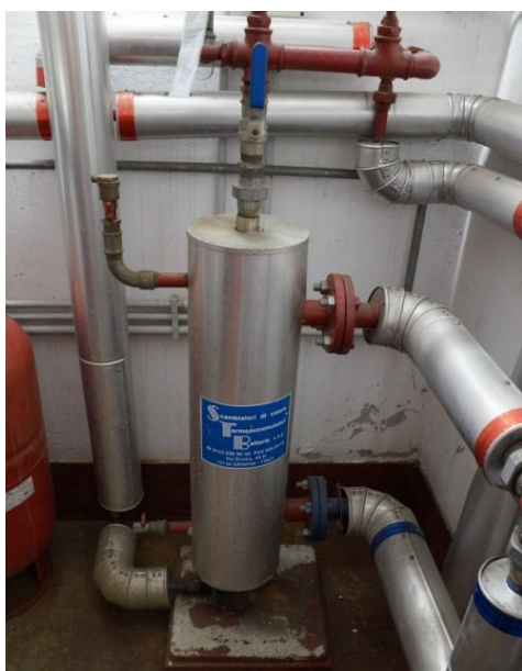
Figura 4.14 - Particolare dello scambiatore di calore
