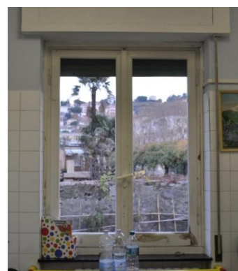
Figura 4.4 - Particolare dei serramenti
