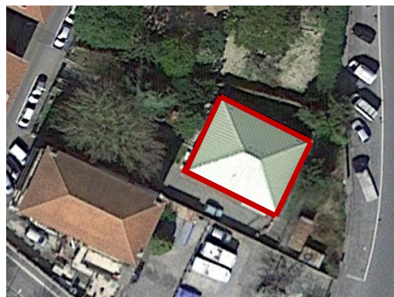
Figura 2.2 - Vista satellitare dell'edificio (Fonte: Google Earth)
